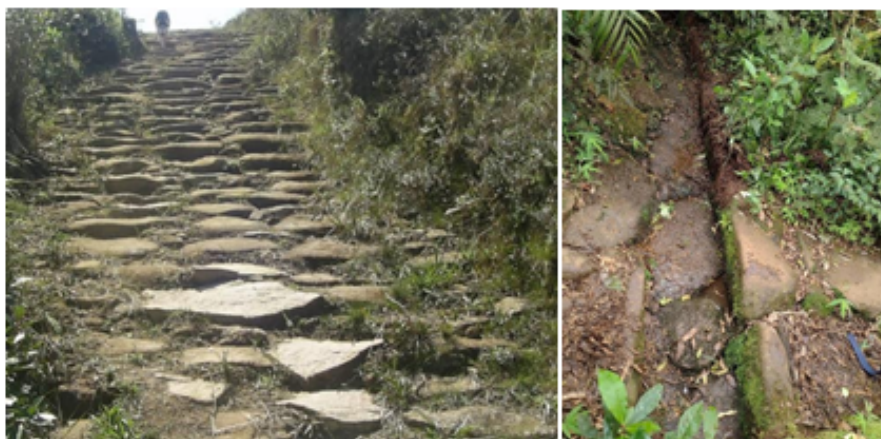
Figura 1 - Vista da escadaria de pedra e canaleta de drenagem na trilha do Monte Crista.
